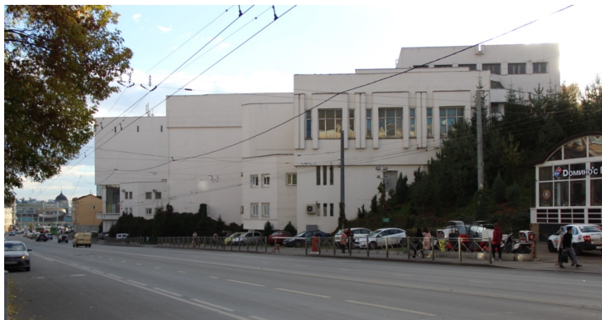
Рис. 1. Здание КСК КФУ «Уникс», построенное на склоне оврага (ул. Пушкина)
